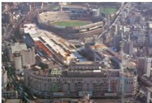
大阪球場(手前は高島屋) (提供:南海電気鉄道株式会社)
