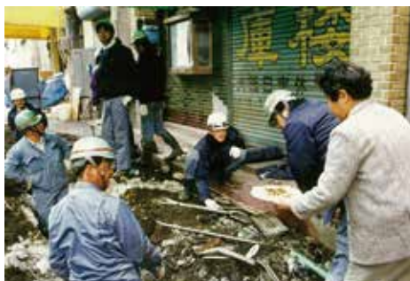
阪神・淡路大震災の復旧現場 地域のお客さまの温かい励ましが復旧の支えに
